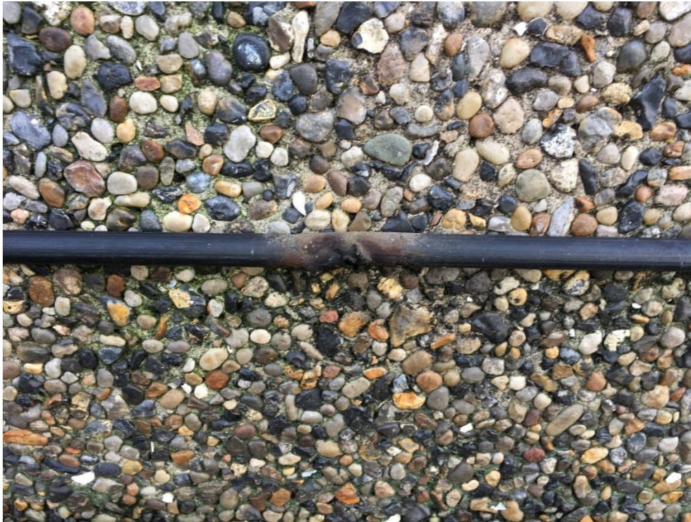
Foto 3. Eksempel på skade på kabelbeskyttelse.
