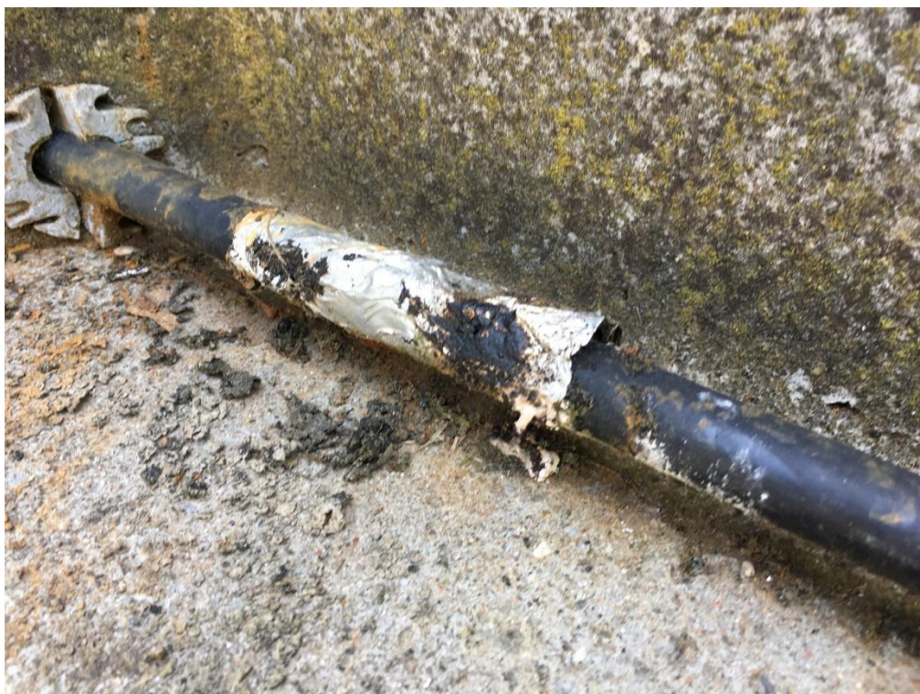
Foto 9: Eksempel på ældre reparation med bitumenbaseret tape som bør undersøges nærmere/skiftes. Metoden vurderes ikke at have den fornødne ydeevne og holdbarhed.
