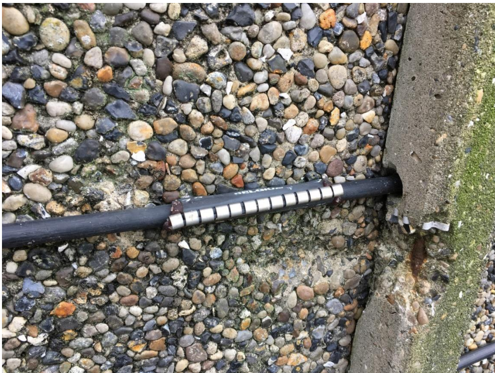
Foto 7. Eksempel på reparation ved anvendelse af krympeflex/lynlås muffe, som vurderes at have den fornødne ydeevne og holdbarhed.
