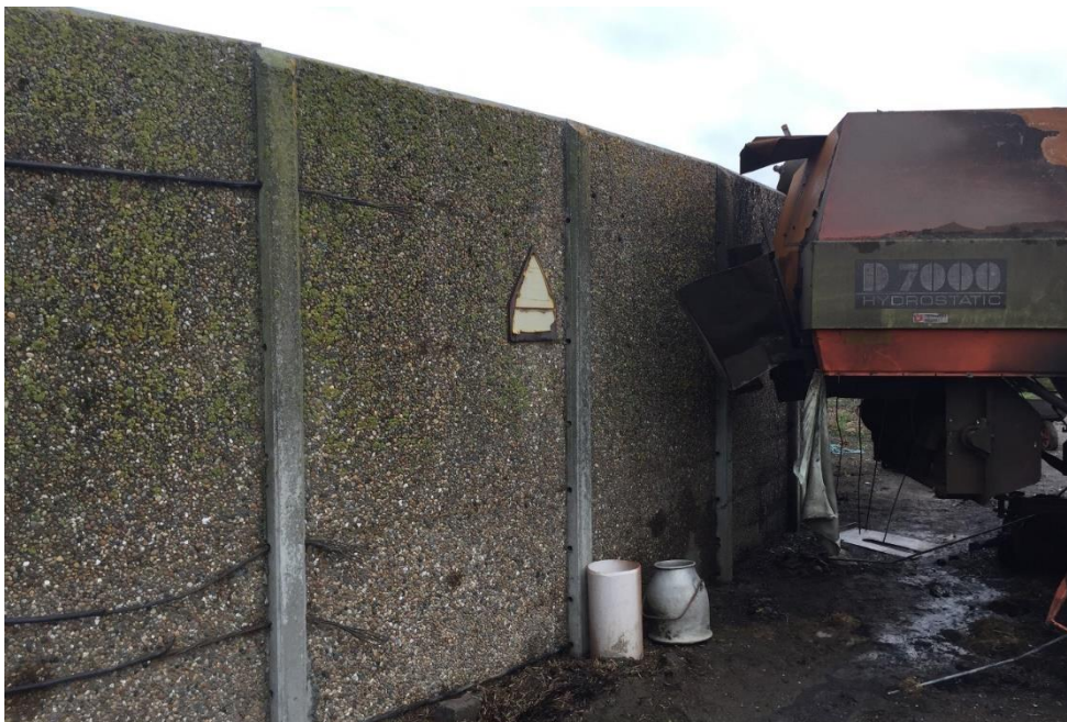
Foto 1. Omfattende skader på kabler efter brand.
