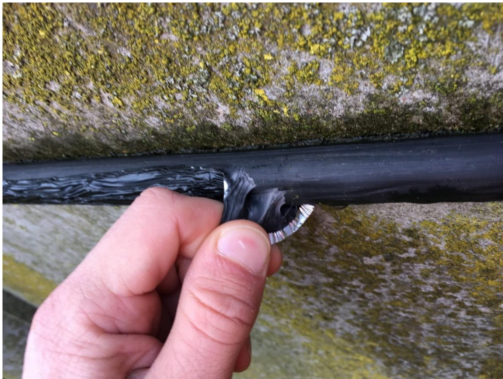
Foto 8: Eksempel på reparation med ukendt tapeprodukt, som vurderes ikke at have den fornødne ydeevne og holdbarhed.
