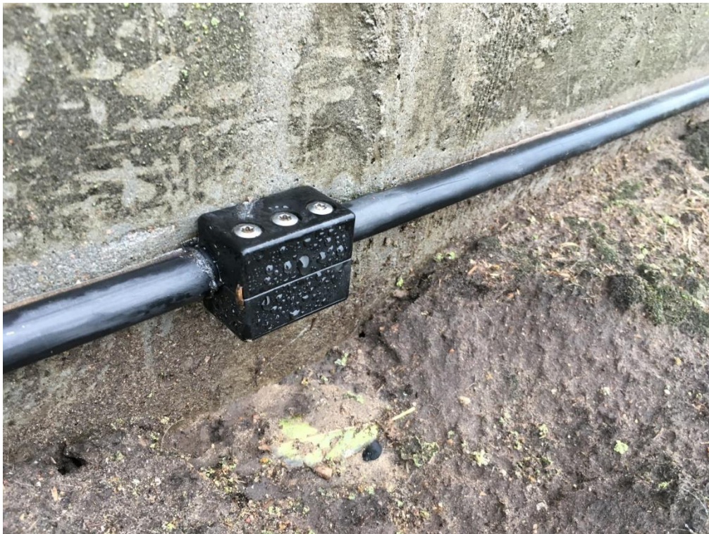
Foto 5: Eksempel på reparation af kabelbeskyttelse på Spæncom beholder, som vurderes at have den fornødne ydeevne og holdbarhed.
