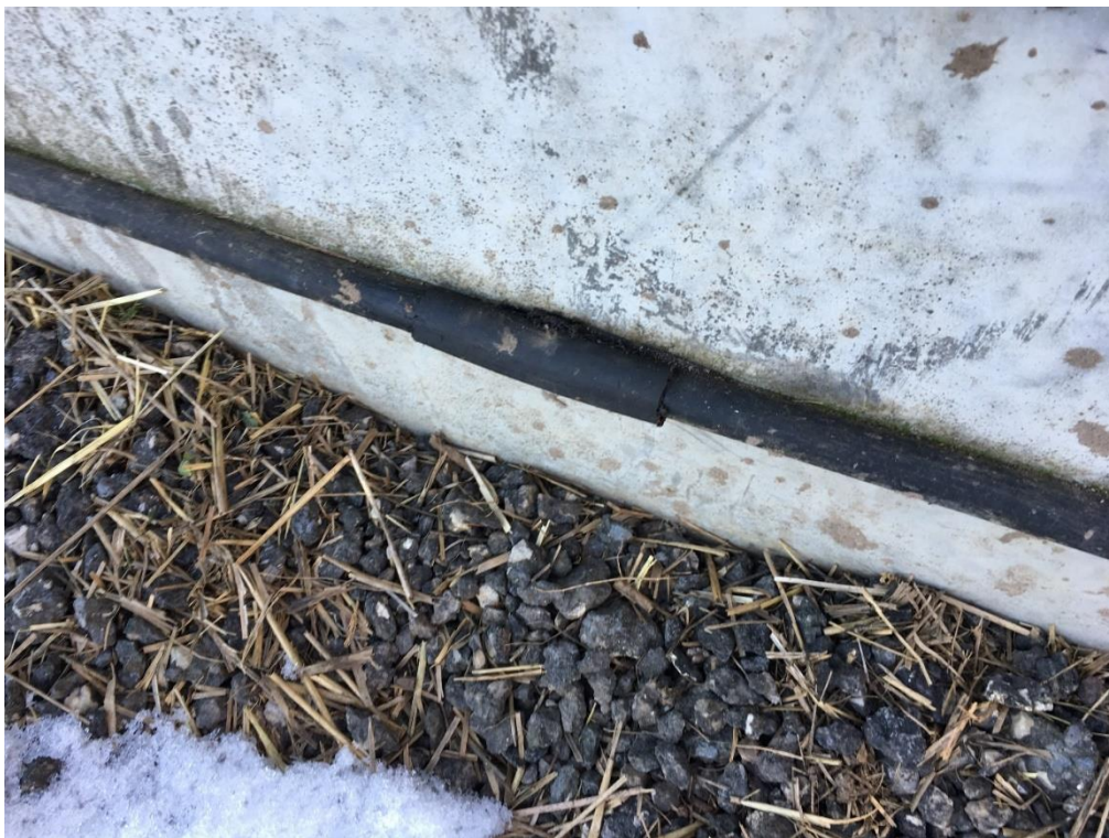
Foto 11. Eksempel på reparation med udskåret plastkappe, hvor der er sat en plastkappe udover. En sådan reparation vurderes ikke at have den fornødne ydeevne og holdbarhed.
