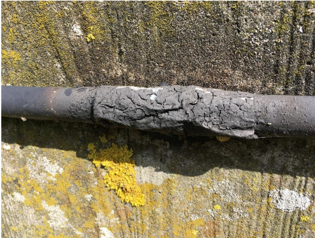
Foto 10: Eksempel på reparation med formentlig bitumenbaseret tape, som efterfølgende er sprøjtet over med et tectyl lignende produkt. Metoden vurderes ikke at have den fornødne ydeevne og holdbarhed.
