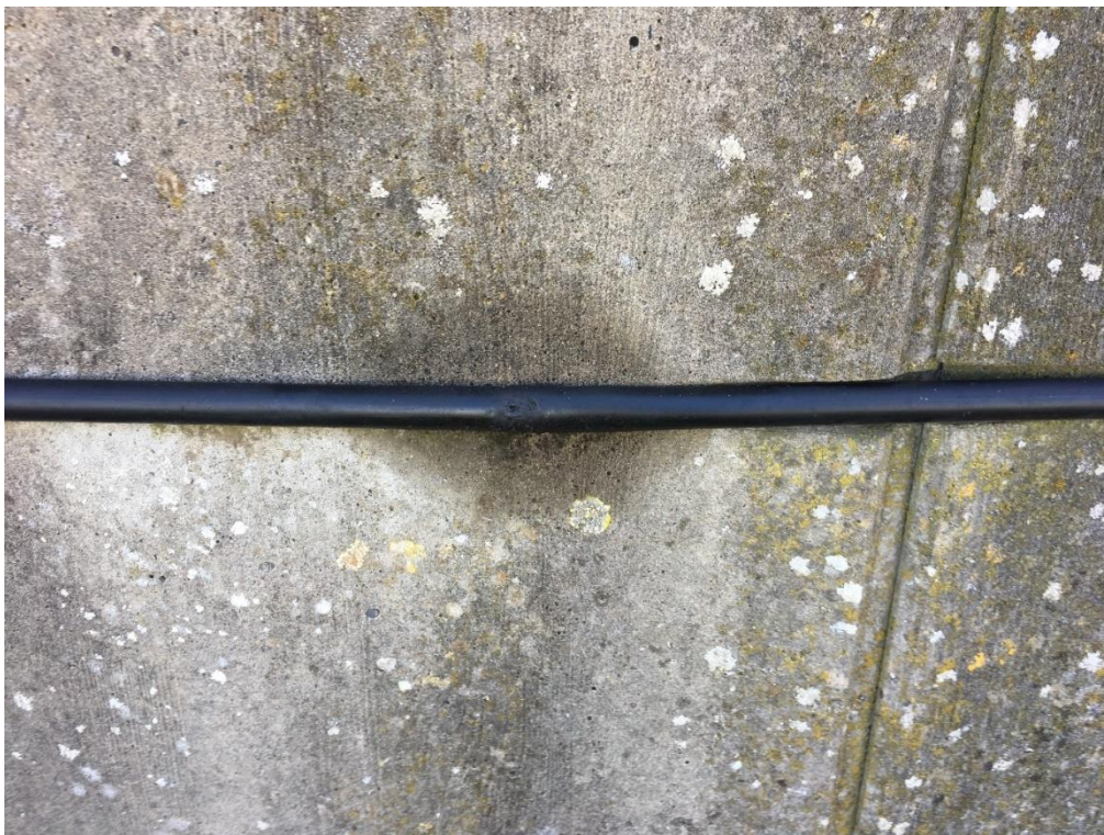
Foto 4. Eksempel på skade på kabelbeskyttelse. I nogle tilfælde er skader nemme at se, da fedt fra kablet trænger ud på betonoverfladen og mørkfarver denne.
