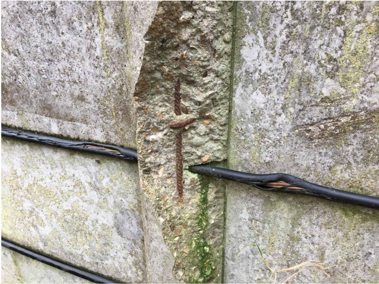
Foto 2. Større skader på kabelbeskyttelsen efter påkørsel.
