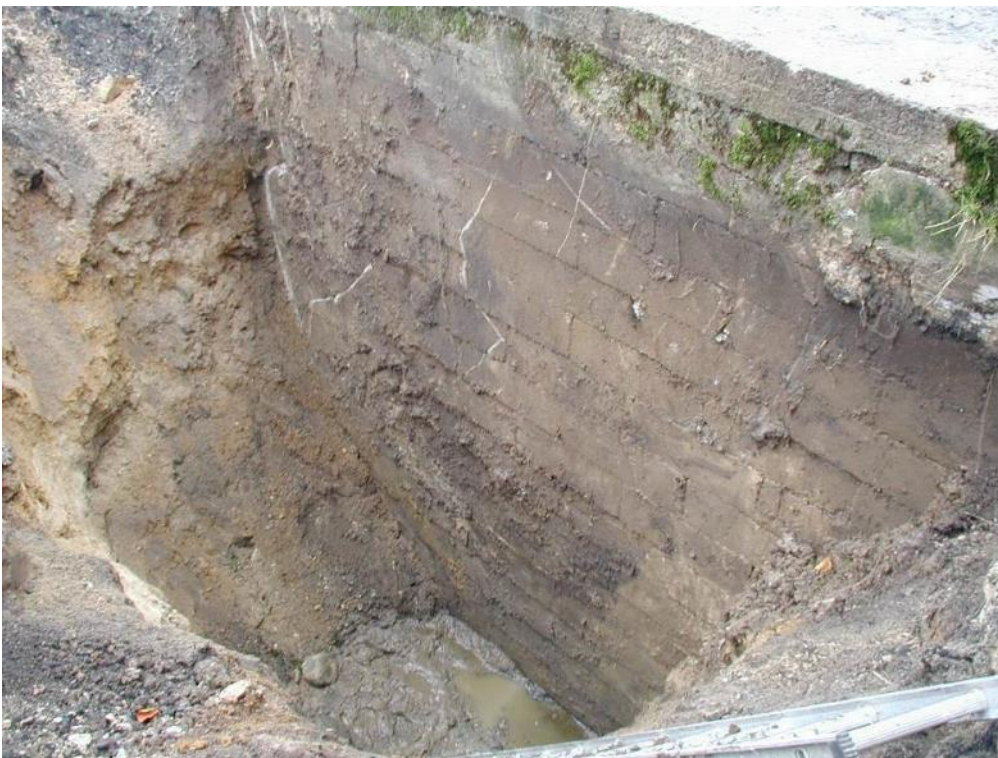
Foto 35: Ved beholdere uden kabler kan opgravningsstedet vælges frit. Her er gravet op ved en blokstensbeholder.
