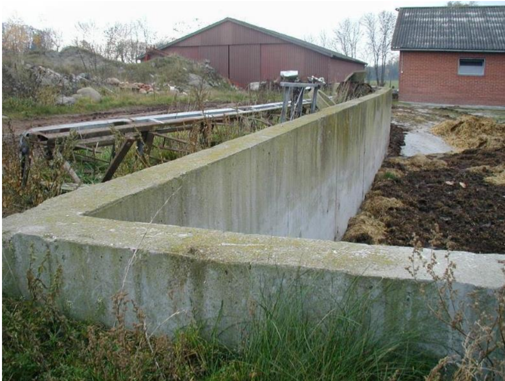
Foto 33: Dette er også en betonbeholder (lagune), der skal kontrolleres, hvis indholdet af flydende husdyrgødning er over 100 m 3 .
