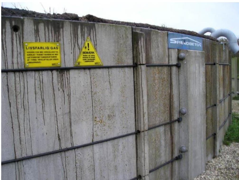
Foto 6: Beholdere fra Spæncor har udvendige kabler. Beholderen har låseelement til fastholdelse af kabler.
