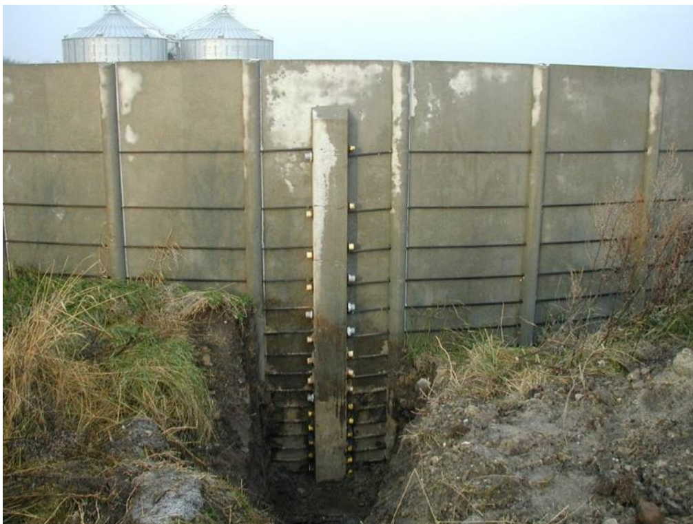
Foto 8: TC-tanken findes i få eksemplarer fra 1994-95. Den har udvendige kabler. Beholderen har låselement til
