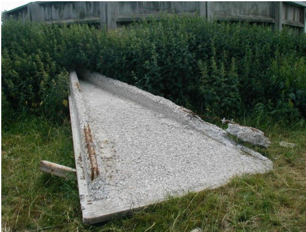
Foto 50: Beholderlåg (undersiden) fra gødningsbeholdere. Det er kraftigt eroderet som følge af manglende ventilation og en beholdervæske, der tilsættes industriaffald.
