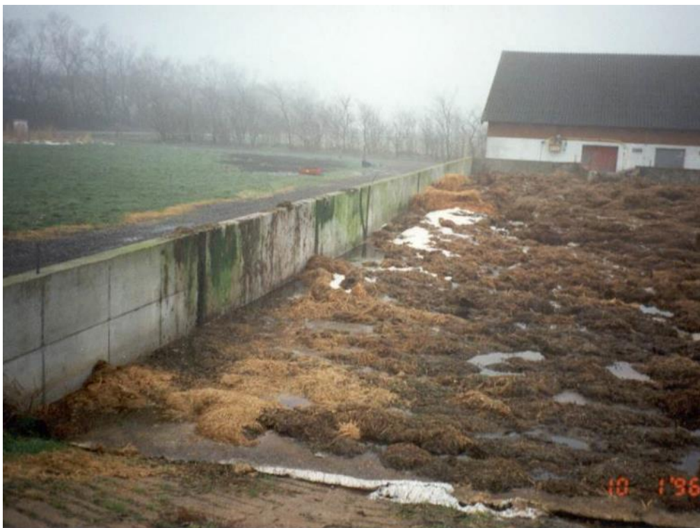
Foto 32: Lagune af beton. Opbygning og udseende af laguner kan være noget forskellig.
