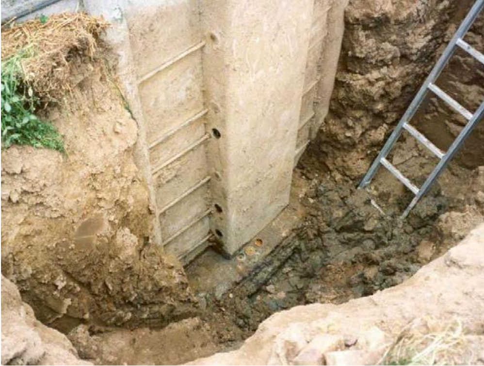
Foto 34: Opgravning skal ske til niveau med bund. Ved beholdere med låseelement for kabler foretages opgravningen som her, så såvel kabler som låse kan kontrolleres.
