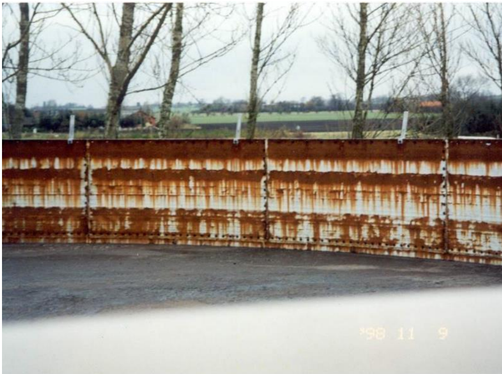
Foto 57: Overfladebeskyttelsen på indersiden af denne stålbeholder er stort set forsvundet og pladerne ruster.
