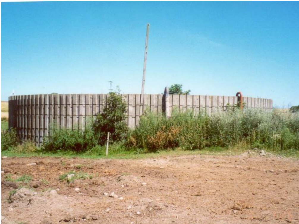
Foto 10: Møn beholder med et karakteristisk udseende. Møn beholder har udvendige kabler (under tilsynet skal det være muligt at færdes rundt om beholderen).
