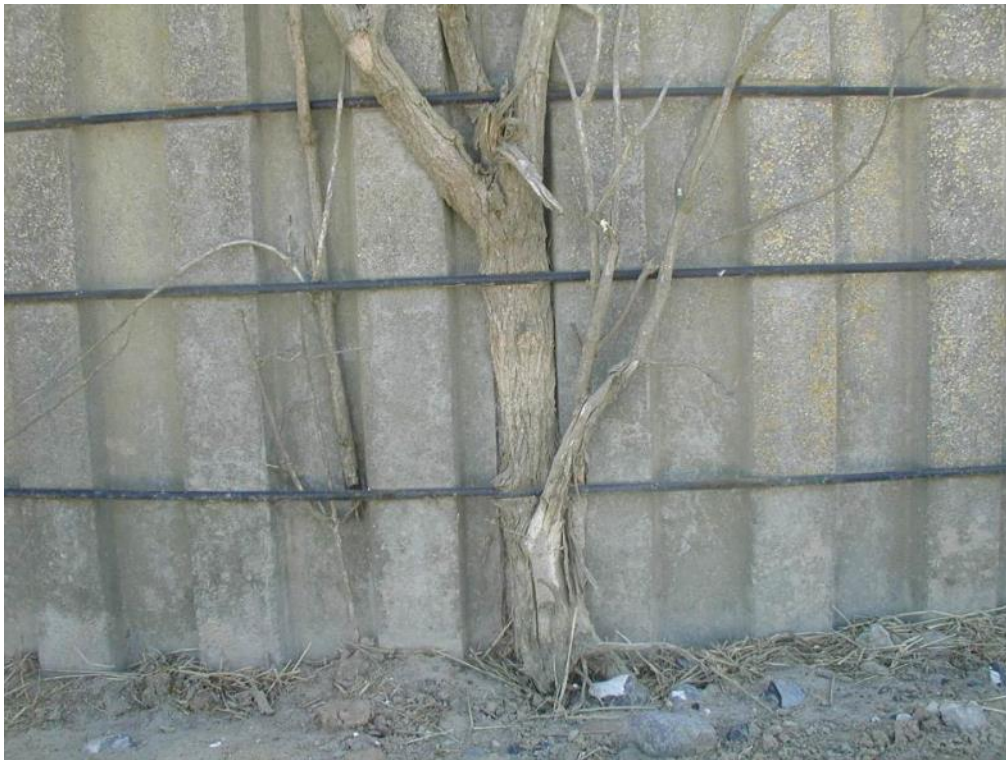
Foto 49: Møn tank med udvendige kabler. Træet er nu fjernet.
