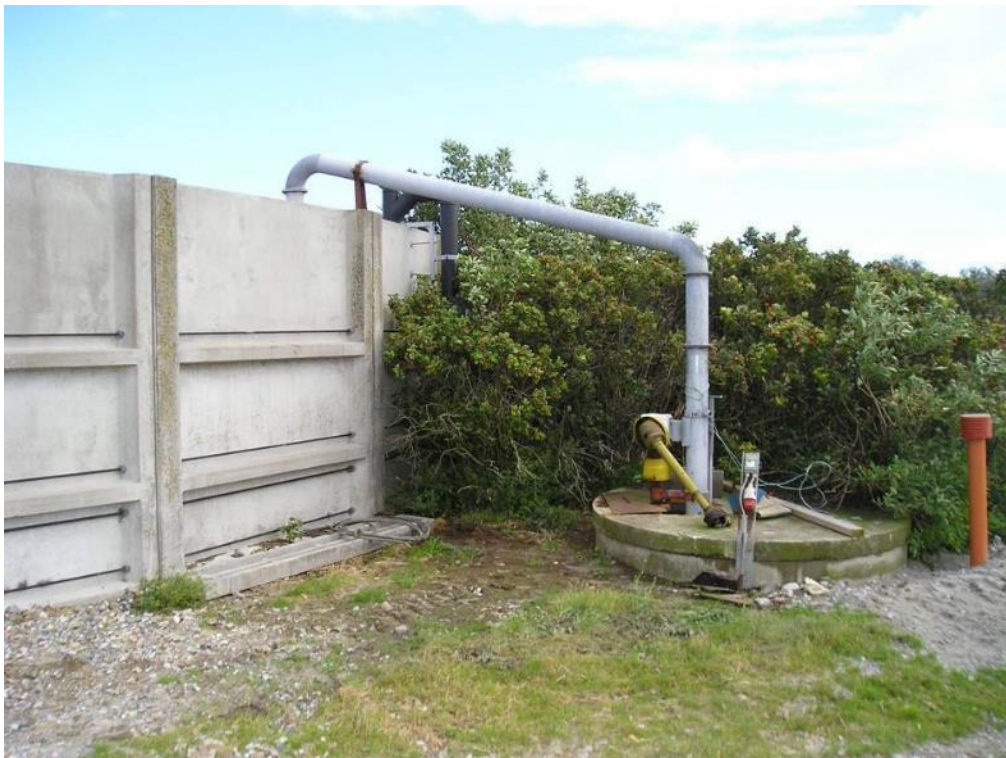
Foto 53: Det kan være svært at kontrollere en beholder, hvis der er tæt beplantning helt op til beholderen. Bevoksning i en afstand af min. 1 meter fra beholderen skal derfor være helt fjernet inden selve eftersynet.
