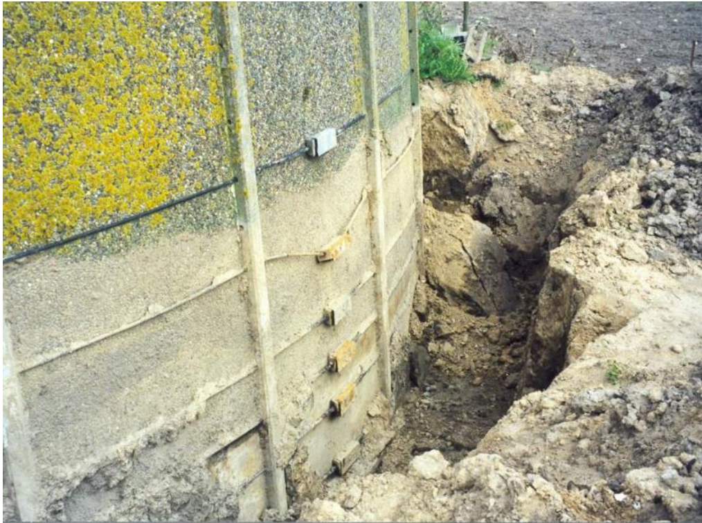
Foto 36: Ved denne beholder er alle samlinger i kabler samlet over hinanden. Normalt vil de sidde spredt og der er ikke sikkert, at der er samling der hvor der graves op. Det ses, at et kabel er sprunget.
