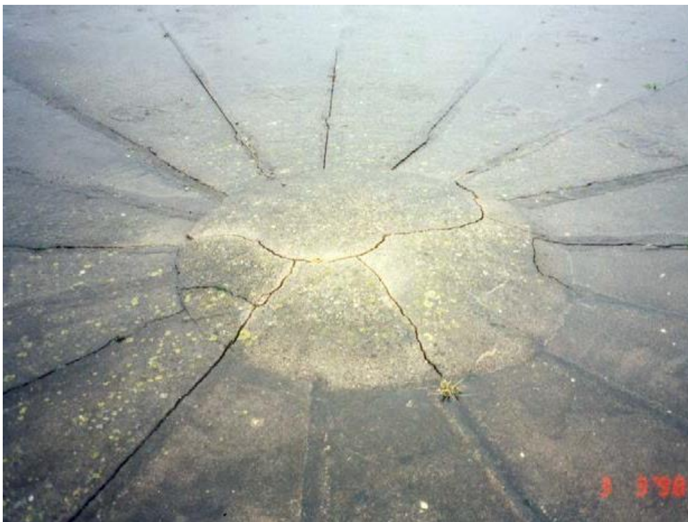
Foto 51: Dette er centret af et beholderlåg (set ovenfra). Revnerne antyder, at der har været bevægelser, antagelig som følge af opskudt bundplade.
