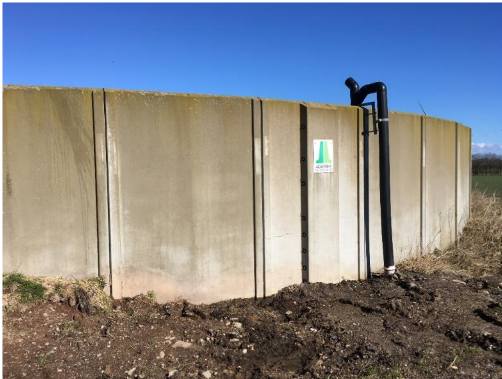
Foto 1: Agri-beholder af betonelementer, der er sammenspændt med skjulte kabler efter montage af elementer.
