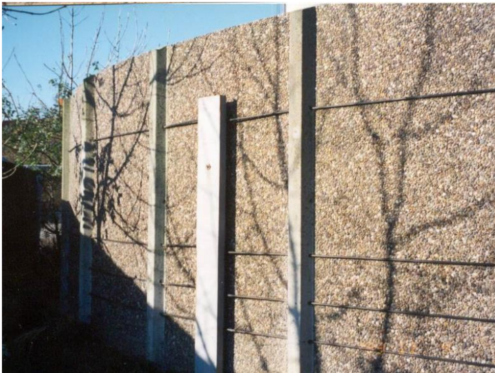
Foto 12: Dette er en ældre Muleby beholder, hvor opspændingen af kablerne på et vinkeljern er skjult bag.
