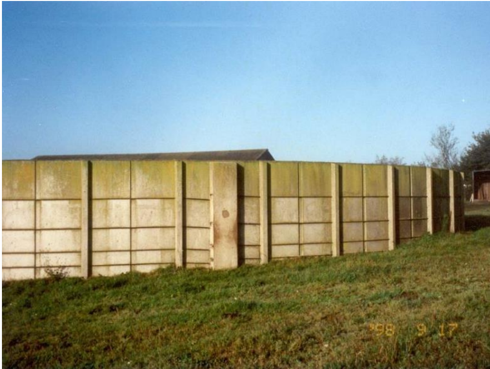
Foto 9: Dette er en Lundsby beholder, der har udvendige kabler og låseelement til fastholdelse af kabler.
