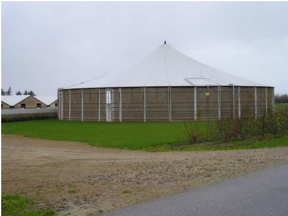
Foto 7: En RC-tank med teltoverdækning. Der er udvendige kabler.
