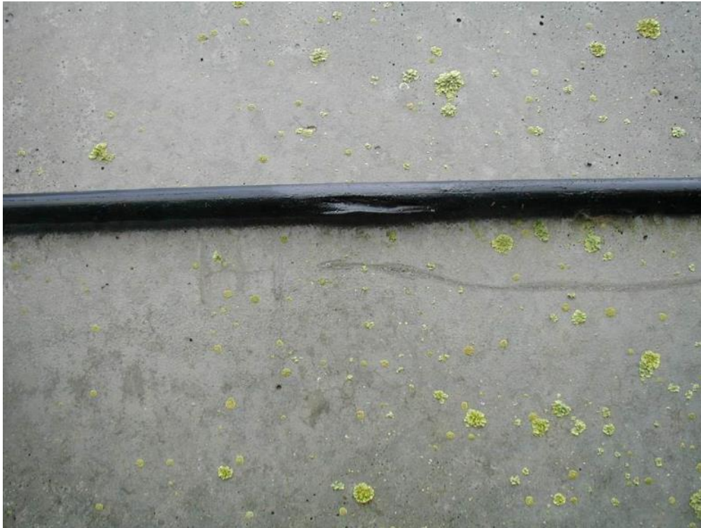
Foto 40: Kabler over terræn har ofte skader fra påkørsel eller andet. I de fleste tilfælde vil skaden blive udbedret af kontrollanten.
