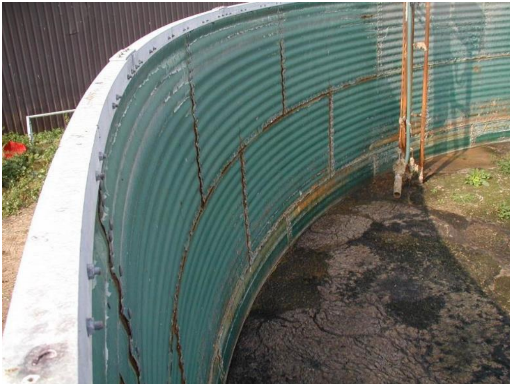
Foto 55: Stålbeholder med bølgeprofil. Det ses, at rusten angriber langs samlingerne mellem vægelementerne.
