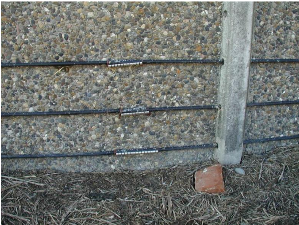
Foto 41: Her er huller i tre kabler udbedret af kontrollanten.
