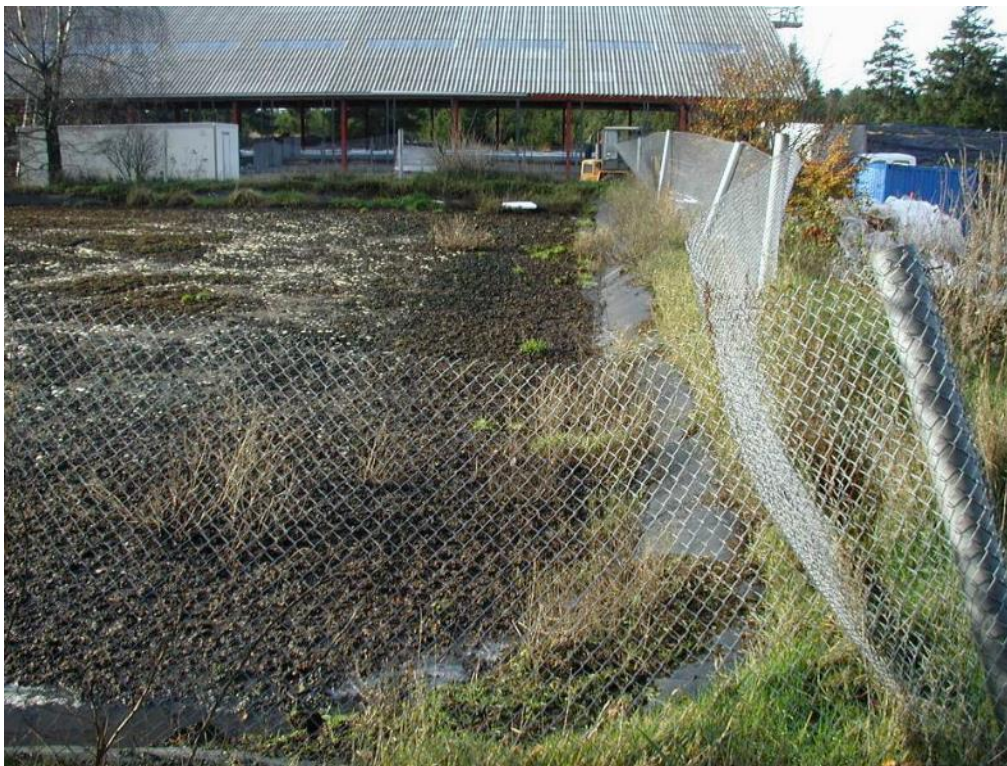
Foto 30: Lagune af plastmembran. Sådanne laguner uden overdækning er opført i perioden 1975 til 1985. Der er i dag kun få i anvendelse, da holdbarheden ikke særlig lang.
