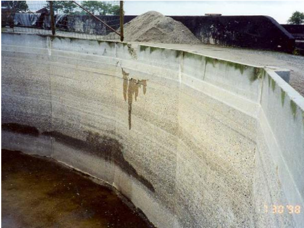
Foto 46: Denne beholder er på hele indersiden skadet af sur væske som kan skyldes opblanding med ensilagesaft eller industriaffald. Der er også en skade som følge af påkørsel (vandindtrængning ses).
