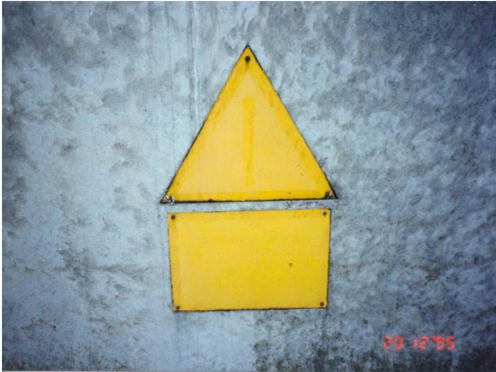
Foto 52: På beholdere skal der i henhold til Arbejdstilsynets bekendtgørelse være forsynet med en læselig advarende tekst. Det indgår ikke i beholderkontrollen at kontrollere disse skilte.
