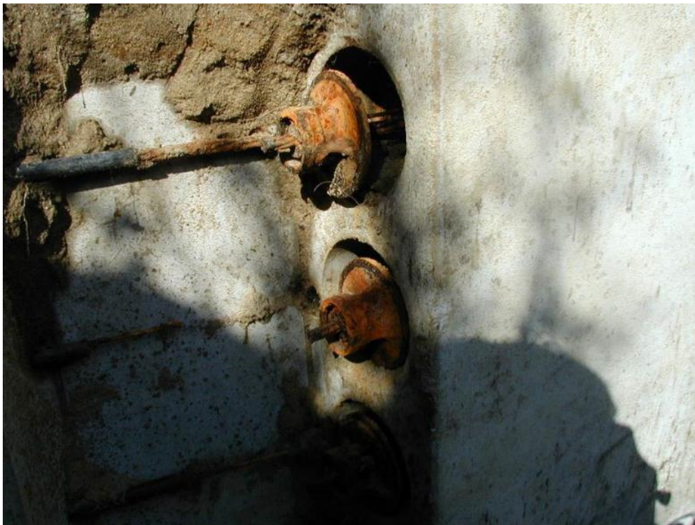
Foto 39: Kabelforankringen er let rusten og en del af kablet (til højre) er ikke beskyttet. Beskyttelse af såvel kabel som forankring samt påsætning af plathætte vil normalt blive udført af kontrollanten.
