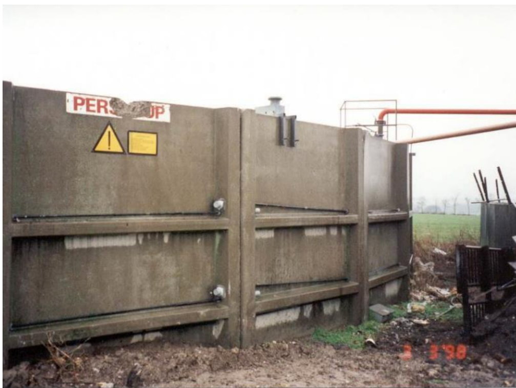
Foto 14: På de fleste Perstrup beholdere er opspændingen sket som vist her. Kablerne er ikke overstøbte på denne beholder.
