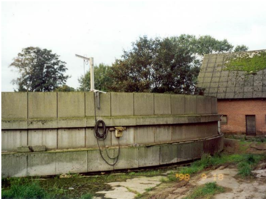
Foto 15: Denne betonbeholder består af betonelementer, hvor der er gummiprofil mellem elementerne. Beholderen holdes sammen af to jernbetonbånd, der er udført efter montage af elementerne. Den findes i meget få eksemplarer.
