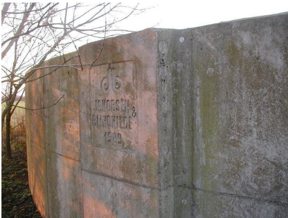
Foto 16: Armeret betonbeholder støbt på stedet.
