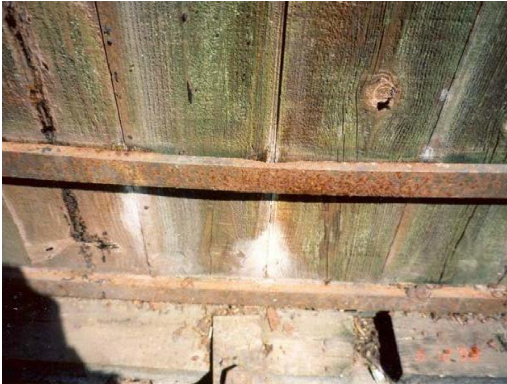
Foto 58: Spændebåndene på træbeholdere er normalt af "sort" stål, der ikke er rustbeskyttet. Hvis en beholder har stået tom et stykke tid, tørrer træet ud og der vil opstå utætheder langs træplankerne. Når beholderen igen fyldes op, vil der sive gylle ud inden.
