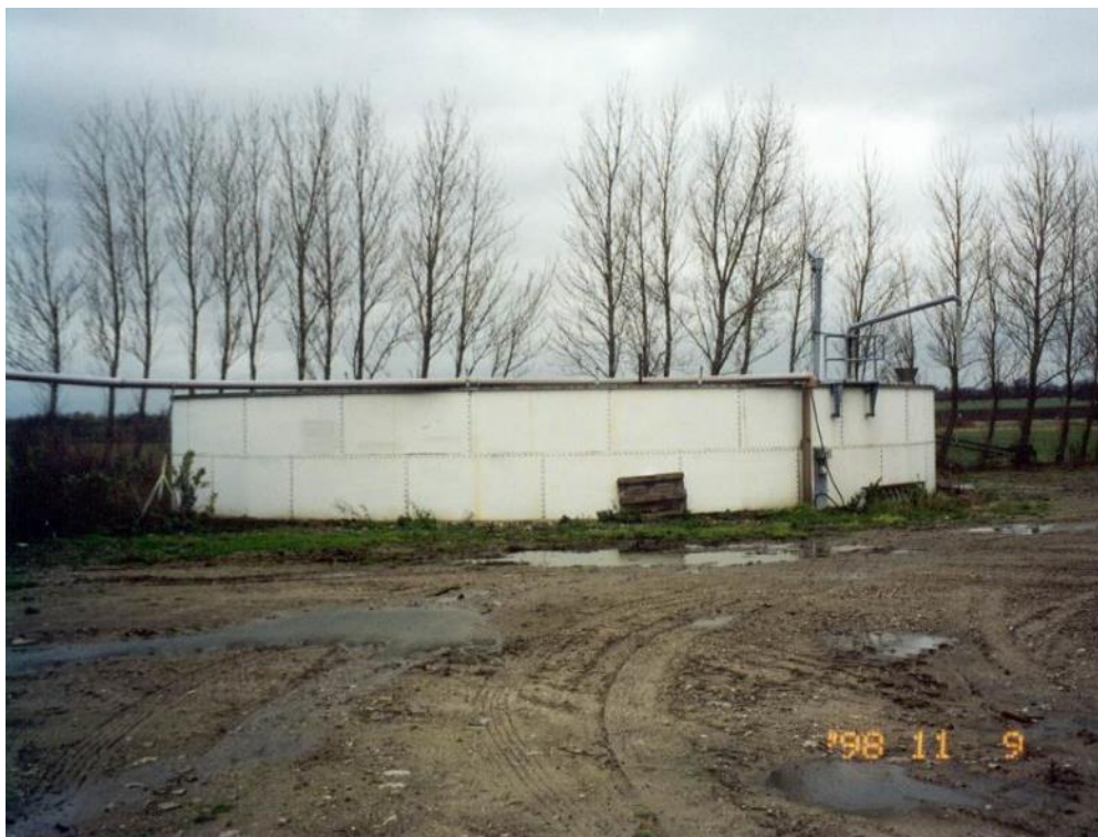
Foto 23: Stålbeholder med væg af flade profiler. Beholderen har fundament under terrænniveau.
