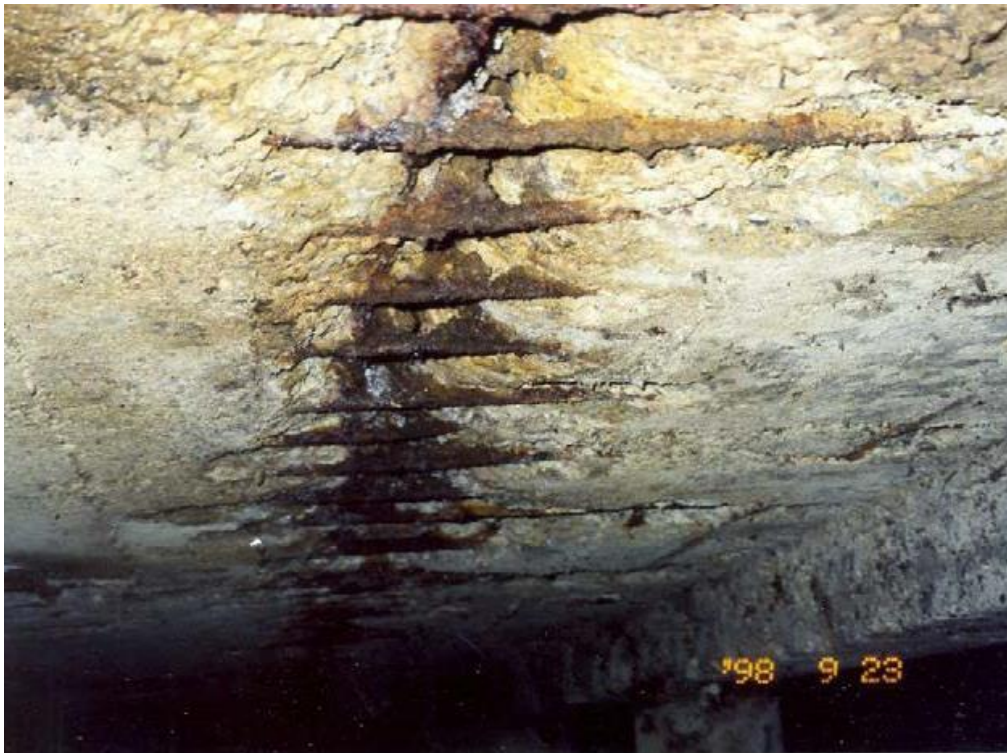
Foto 43: Undersiden af ældre betondæk kan være meget tæret af gyllen som det ses her. Færdsel på et sådant dæk er forbundet med fare for nedstyrtning.
