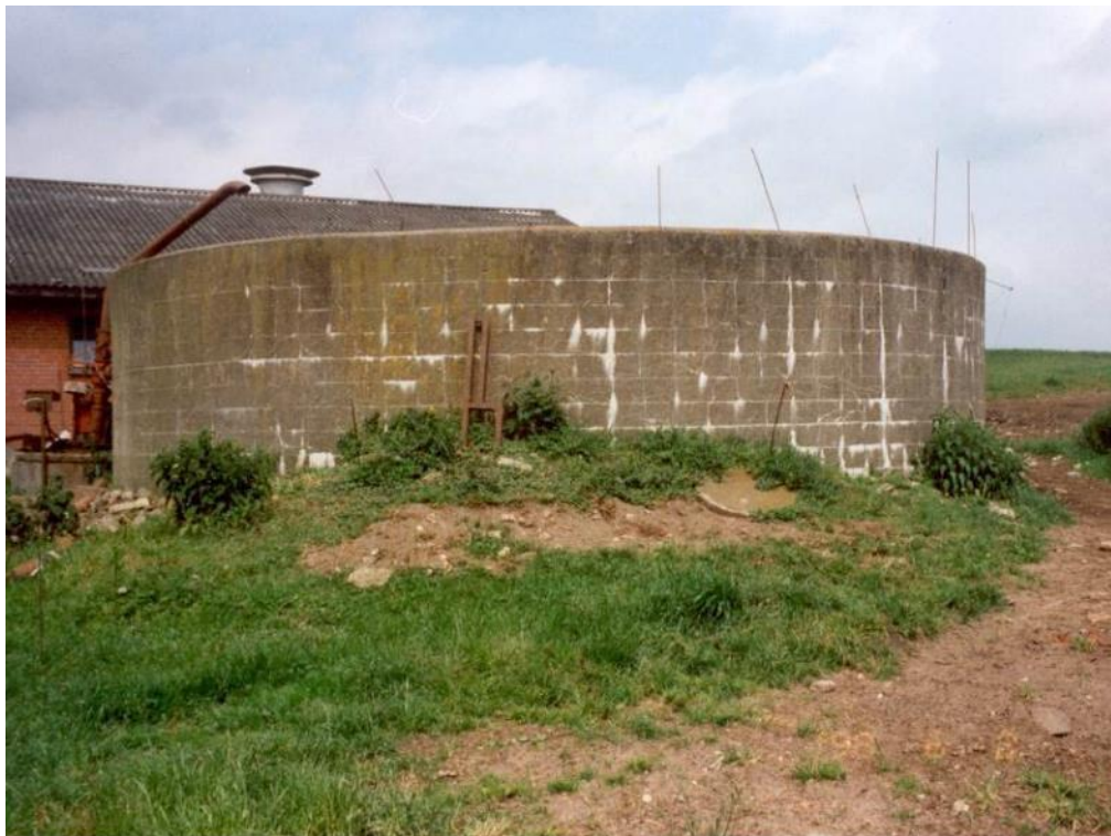
Foto 17: Blokstensbeholder, der er opbygget af krumme siloblokke, 200x500 mm. Blokstensvæggen er armeret og hulrum i blokkene er udstøbt med beton.
