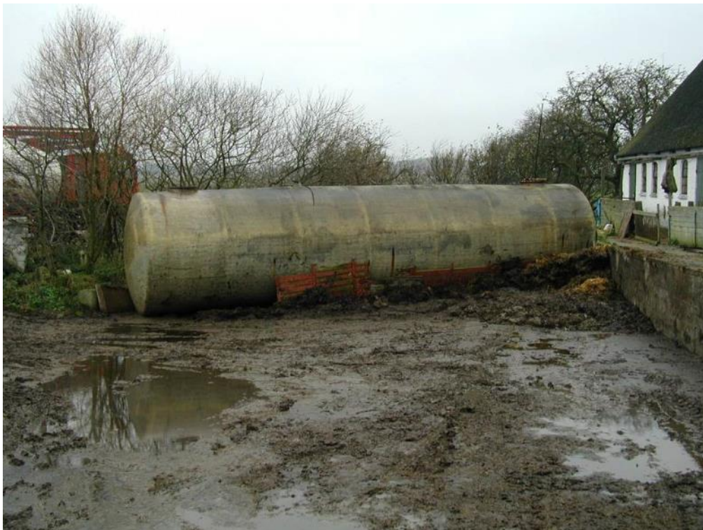
Foto 26: Lukket stålbeholder, der i visse tilfælde kan anvendes til opbevaring af flydende husdyrgødning.
