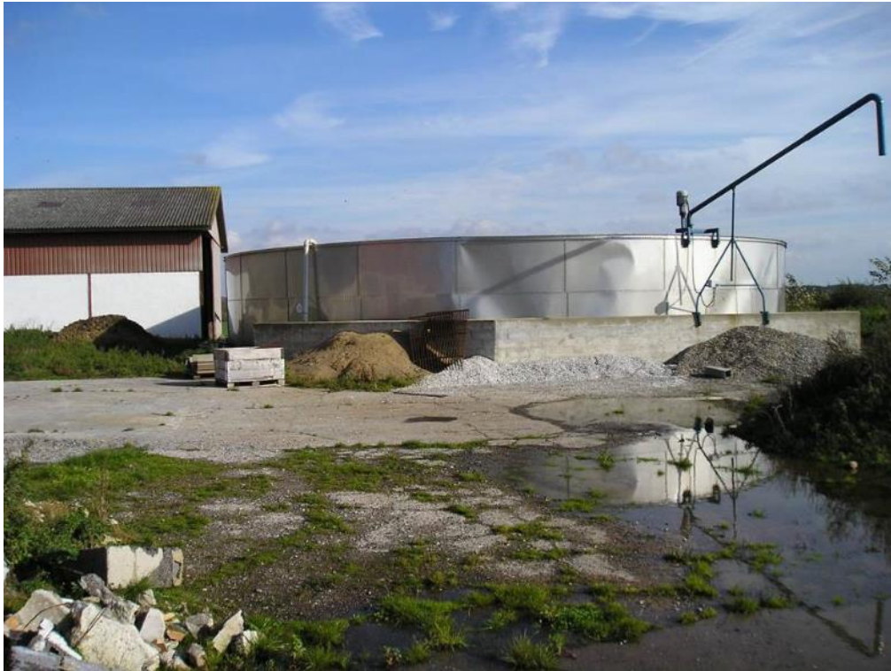
Foto 25: Dette er en beholder i rustfrit stål, delvis nedgravet. Der er ingen tegn på rustangreb. Der er meget få af denne type i Danmark.
