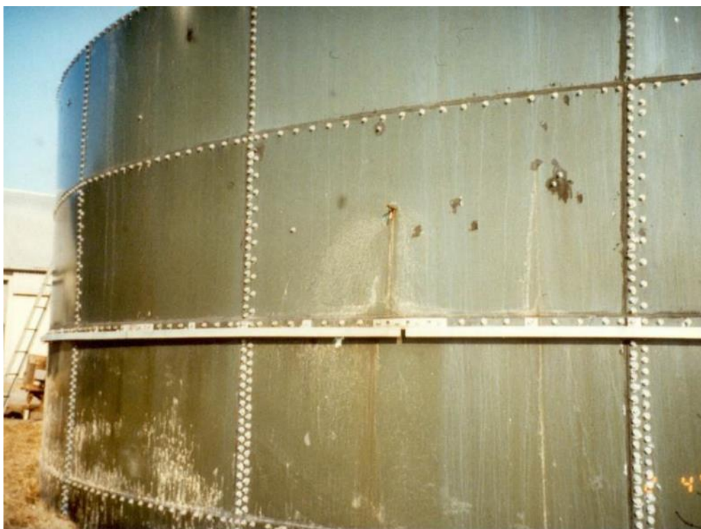
Foto 24: Stålbeholder med væg af flade profiler. Nogle stålbeholdere er som rustbeskyttelse glaserede, men hvis glasuren beskadiges, rustner stålet meget hurtigt.
