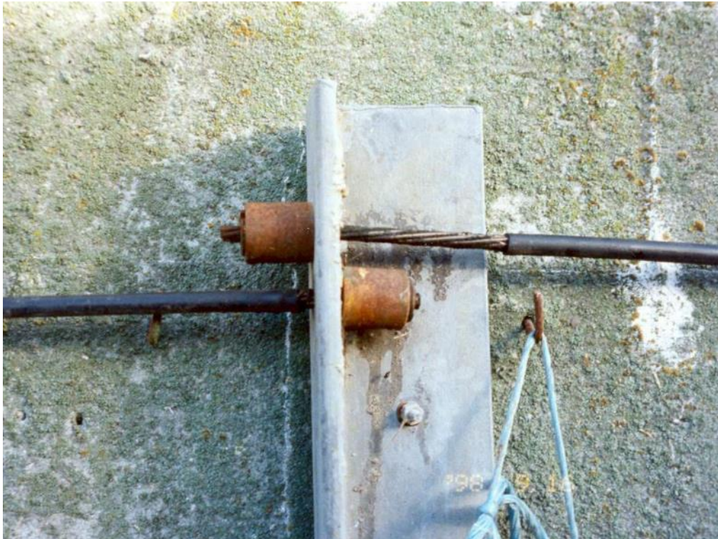
Foto 38: På sprungne kabler vil kabelforankringen normalt sidde løst som her.
