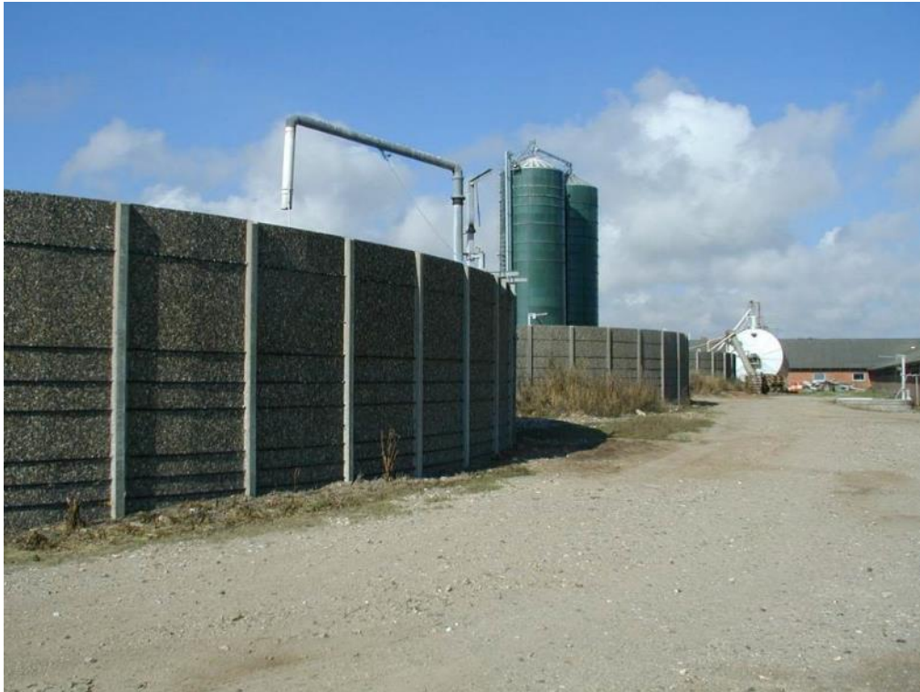
Foto 3: To Muleby beholdere. Muleby beholdere har udvendige kabler.
