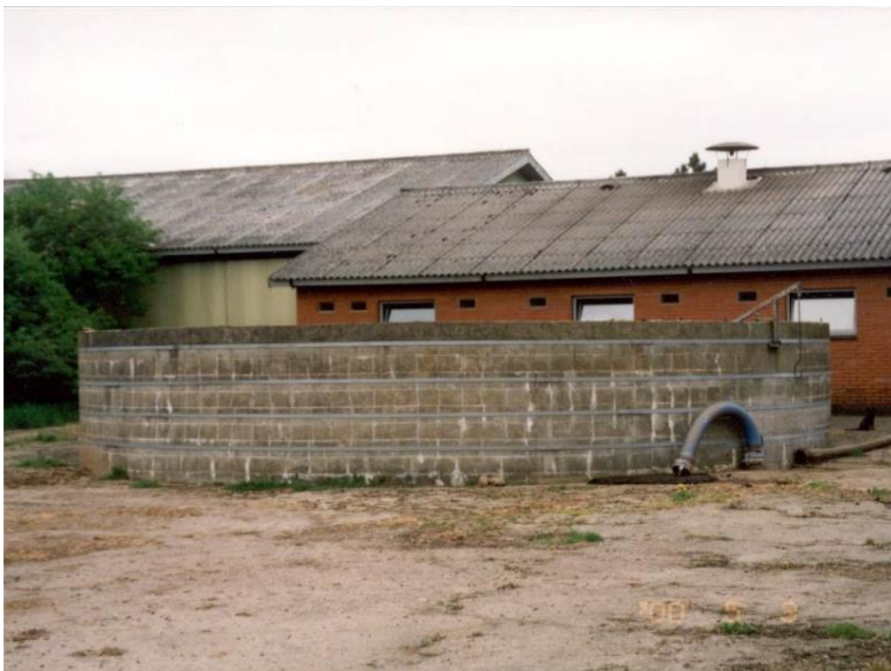
Foto 20: Blokstensbeholder, der er forsynet med spændebånd. Det er afgørende for båndenes positive virkning, at de opsættes af eller i samarbejde med en specialist, der kan vurdere båndenes virkning og den kraft, som de bør spændes til.
