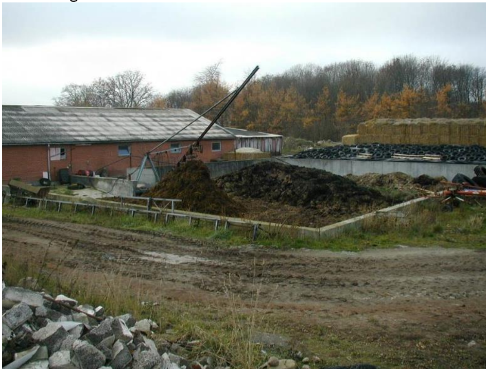
Foto 29: Betonlagune. Denne lagunetype har normalt nedkørsel. Den skal kontrolleres, hvis den kan indeholde over 100 m 3 flydende gødning.
