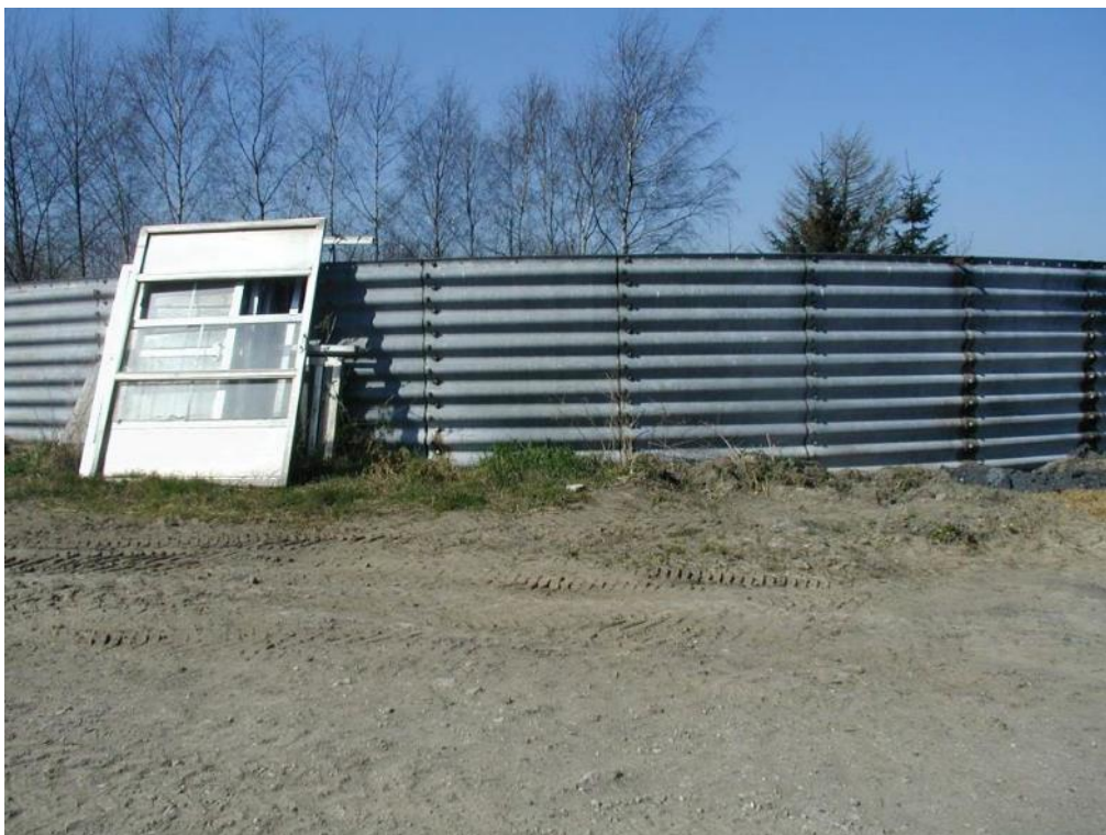
Foto 22: Stålbeholder med væg af bølgeprofiler. Beholderen har fundament under terrænniveau.
