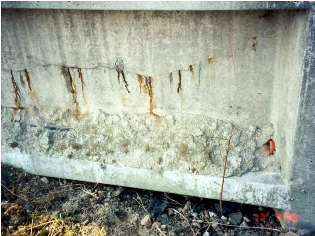
Foto 45: Hvis der siver gylle gennem revnen som her skal der ske en tætning og udbedring på beholderens inderside.
