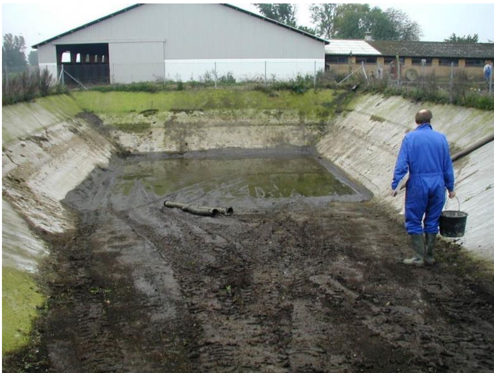
Foto 31: Lagune af fiberbeton.
