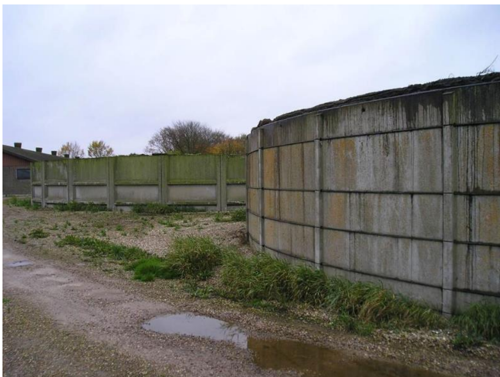
Foto 2: Beholder af betonelementer, der er sammenspændt med synlige kabler efter montage af elementer.
