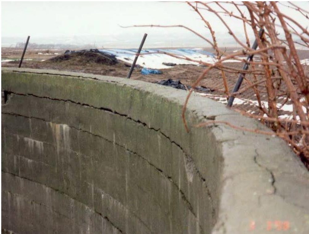
Foto 59: Hvis blokstensbeholderen ikke er opbygget tilstrækkelig solidt, vil vand trænge ned i beholdervæggen, og den vil miste såvel styrke som tæthed. Det er vigtigt, at væggens overside er tæt og med fald, således at vand kan ledes væk.
