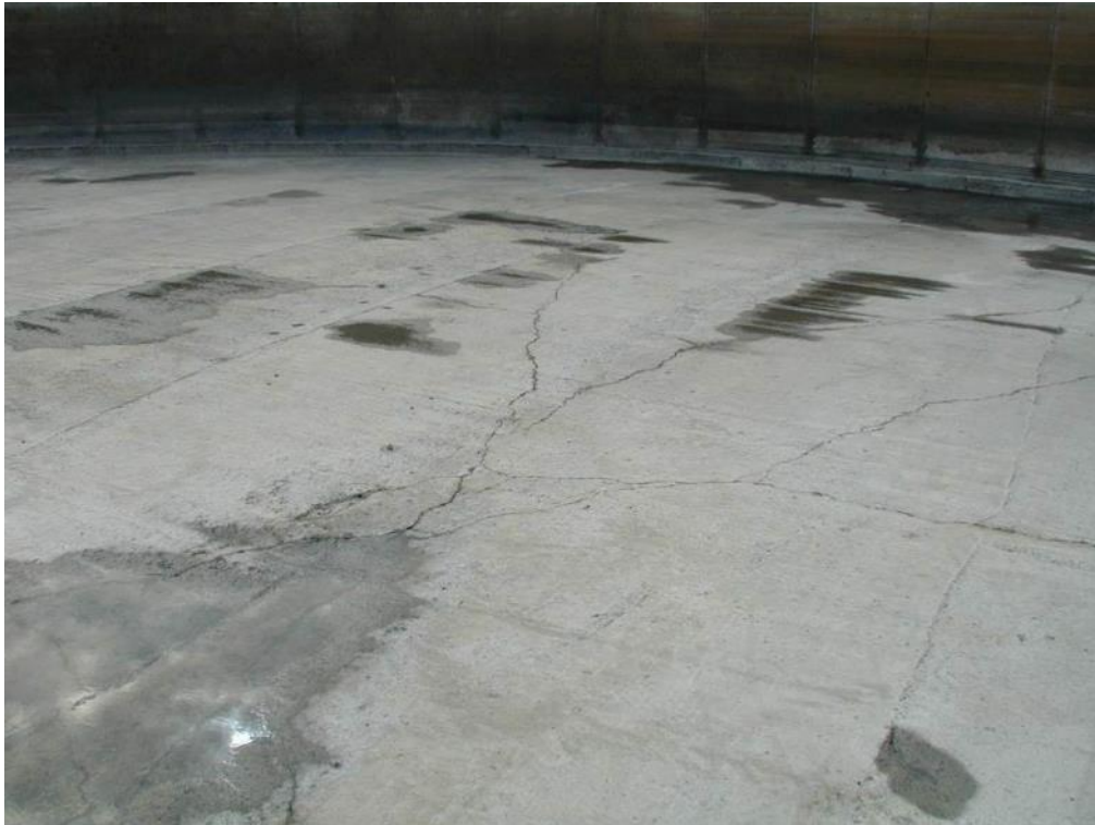
Foto 48: Rengjort bund i beholder. Bunden er revnet som følge af opskudt bund (fra udvendigt vandtryk). Beholderen er utæt, hvilket kunne konstateres som følge af udsivende gylle. Normalt kontrolleres bundplader ikke, da der ikke kræves tom beholder ved kontrol.
