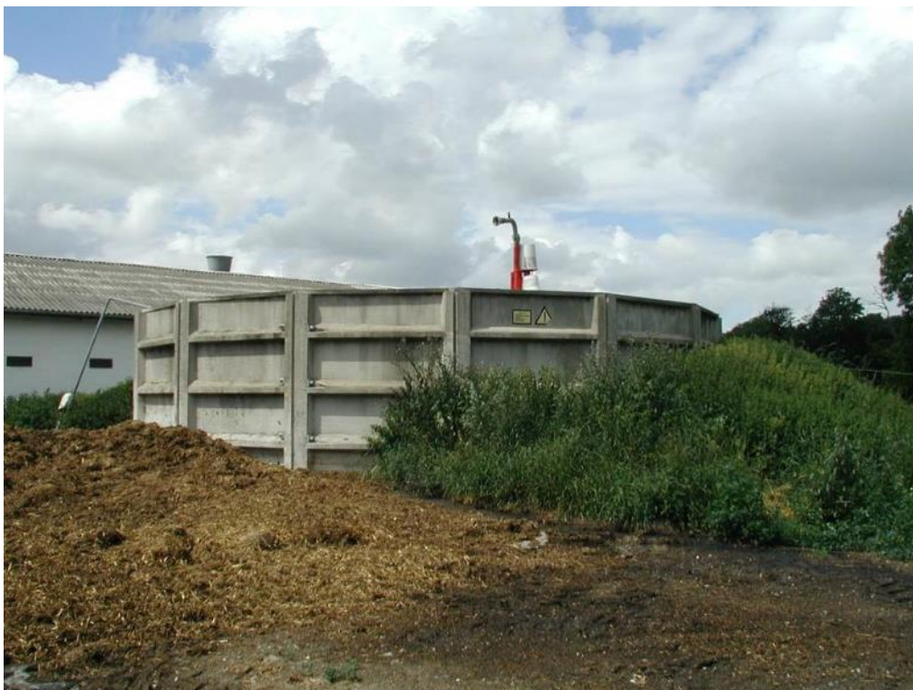
Foto 4: Perstrup beholder med samling mellem 2 elementer. Beholderen har udvendige kabler, som dog kan være overstøbte som her (under tilsynet skal det være muligt at færdes rundt om beholderen).
