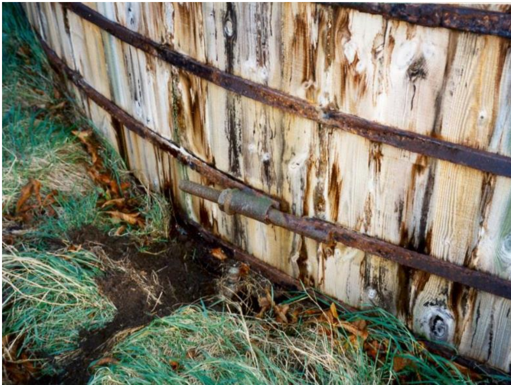
Foto 28: Træbeholdere har bundplade i terrænniveau. Spændebånd er spændt med en boltesamling. De kan også være svejst sammen.
