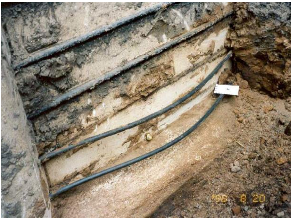
Foto 37: Ved denne beholder er de to nederste kabler sprunget. Der er aldrig problemer med at vurdere om et kabel er sprunget eller ej.
