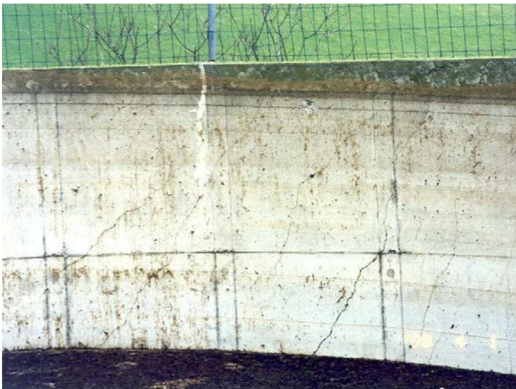
Foto 47: Her ses inderside af beholdervæg. Des ses kraftige revner (beholder er utæt) som følge af uens sætning af underbund. Beholderen er opført på kanten af en skråning.
